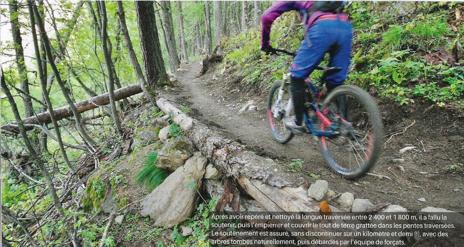
Après avoir repéré et nettoyé la longue traversée entre 2 400 et 1 800 m, il a fallu la soutenir, puis l'empierrement et couvrir le tout de terre grattée dans les pentes traversées. Le soutènement est assuré, sans discontinuer sur un kilomètre et demi (!), avec des arbres tombés naturellement, puis débardés par l'équipe de forçats.
